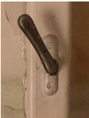
Replika původní půlolivy, masivní mosaz
