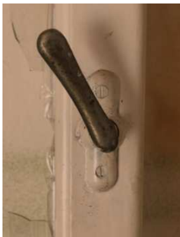
Replika původní půlolivy, masivní mosaz
